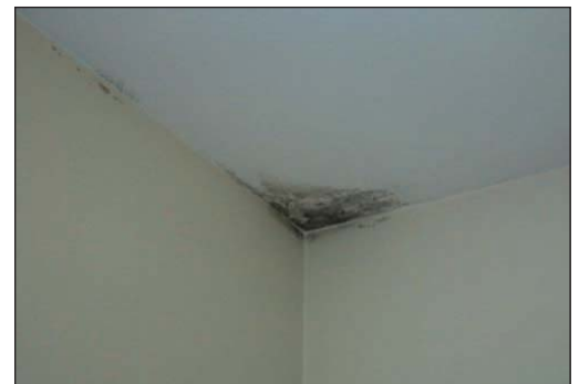
Abb. 18: Schimmelbildung linkes Bild: im Fenstersturz; rechtes Bild: Raumecke, Wärmebrücke
