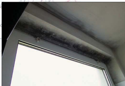
Abb. 18: Schimmelbildung linkes Bild: im Fenstersturz; rechtes Bild: Raumecke, Wärmebrücke
